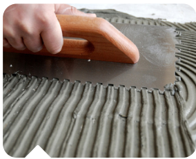
Étendez un lit de mortier mince avec une truelle
